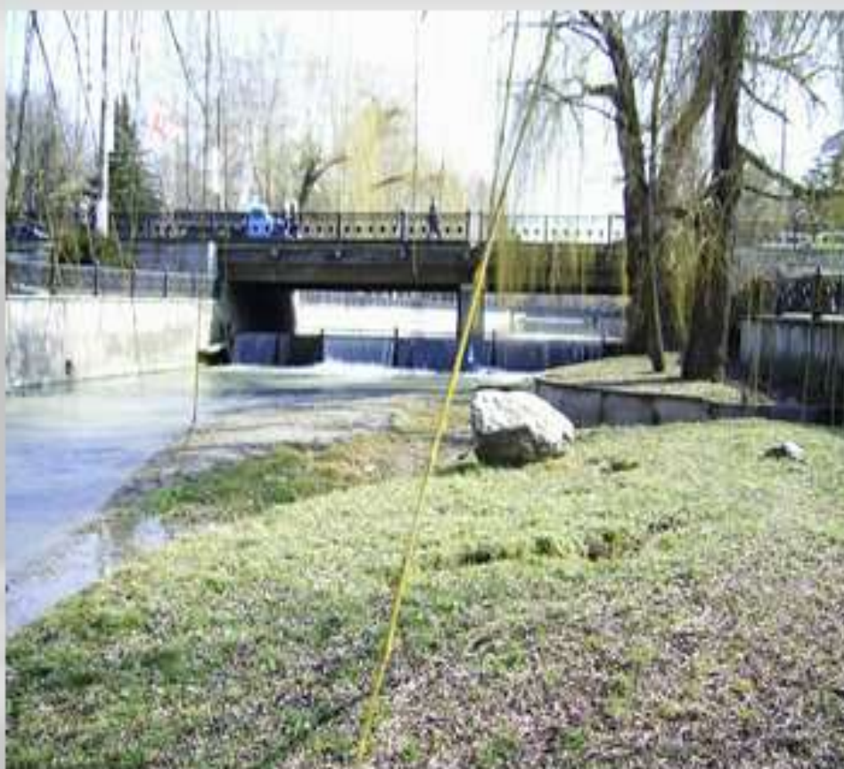
Мост через р. Салгир
